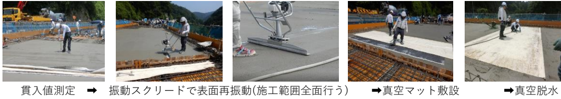
写真 6 表面再振動工法作業の流れ
